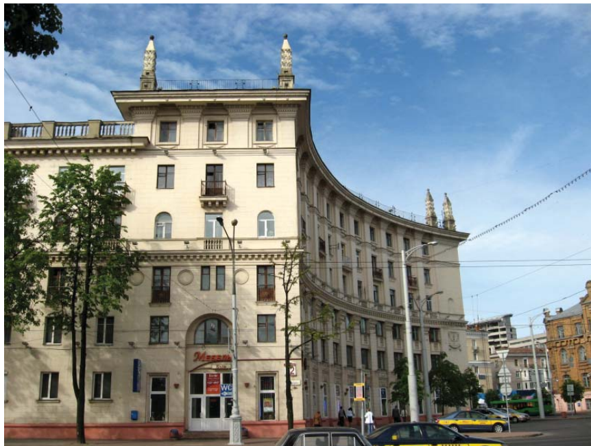
Рис. 165, 166. Здание жилого дома по улице Свердлова, 22 (пересечение с улицей Кирова) – передний и боковой фасад. 1952. Минск. Архитекторы Б. Рубаненко, Л. Голубовский, А. Корабельников
