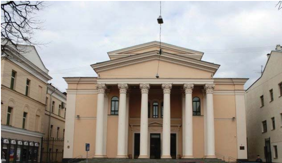
Рис. 178. Здание Национального академического драматического театра им. М. Горького. Реконструкция 1948–1950 гг. Минск. Архитектор М. Бакланов
