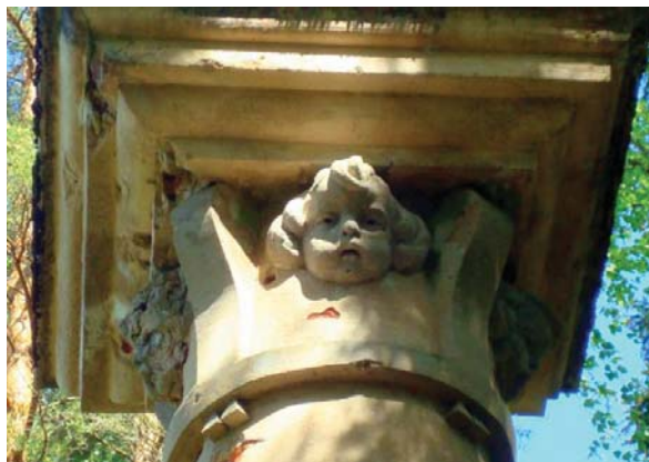
Рис. 185. Фрагмент колонны в Леонполе. Капитель, декорированная лепными головками путти. Фото: radzima.org
