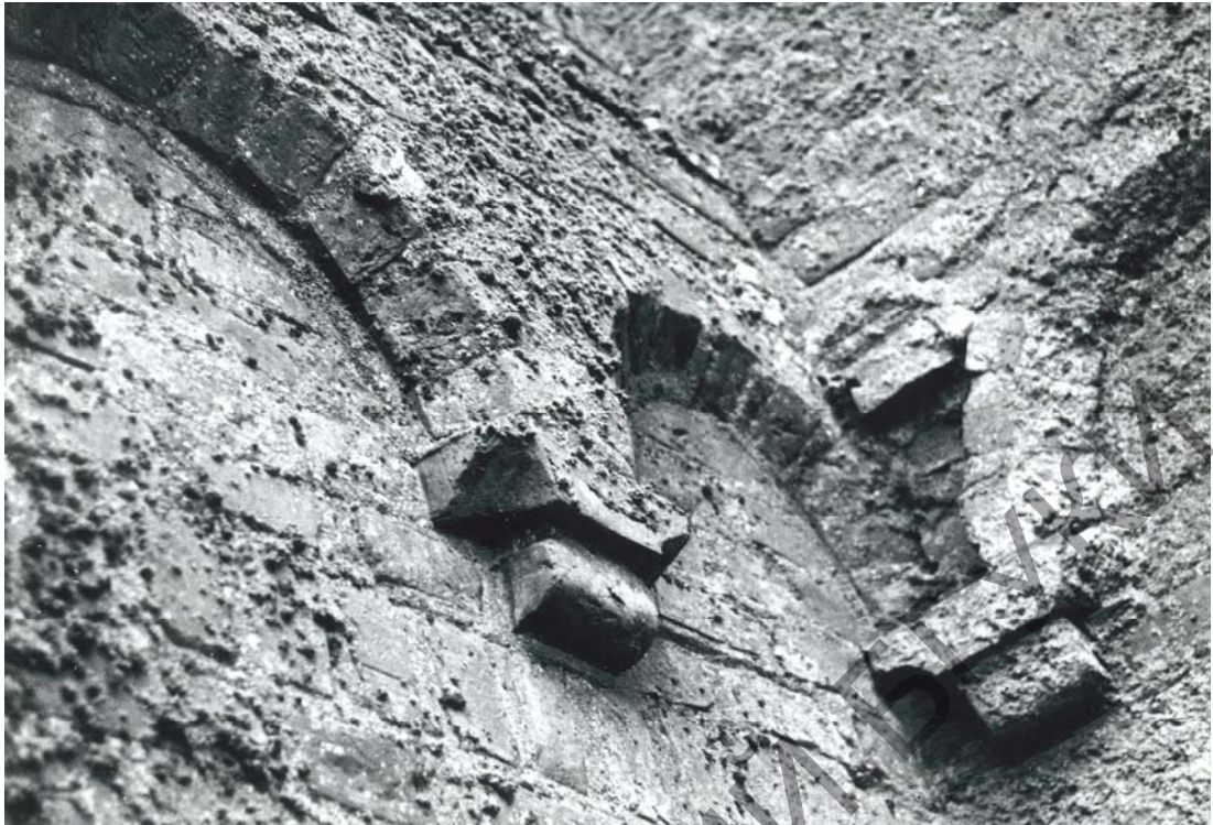
129. Фрагмент дэкартыўнага аздаблення з профільнай цэглы XVI ст. Царква ў Сынкавічах (Зэльвенскі раён)
