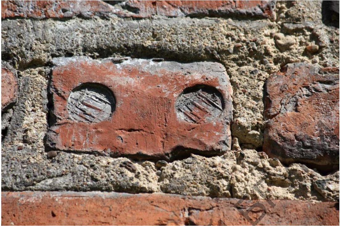
123. Клеймы на цегле з віленскіх гатычных будынкаў. Паводле В.Левандаўскаса
