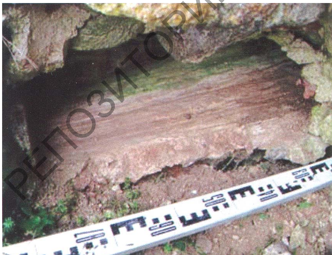
151. Арматурны тунель з адбіткам фактуры драўлянага звязу. Крэўскі замак. Малая вежа. Паводле А.Дзярновіча
