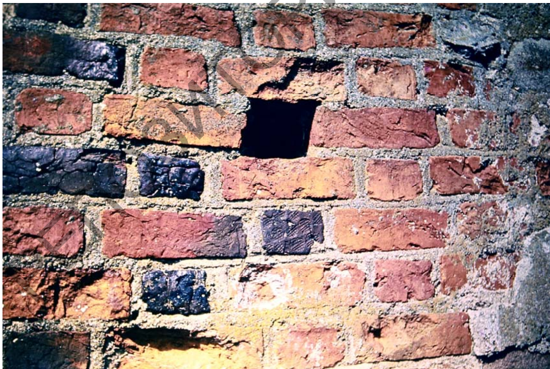
153. Адтуліна ад бруса рыштаванняў, ніжэй клінкерная цагляна з клеймамі. Цэнтральная вежа Мірскага замка. Фота аўтара
