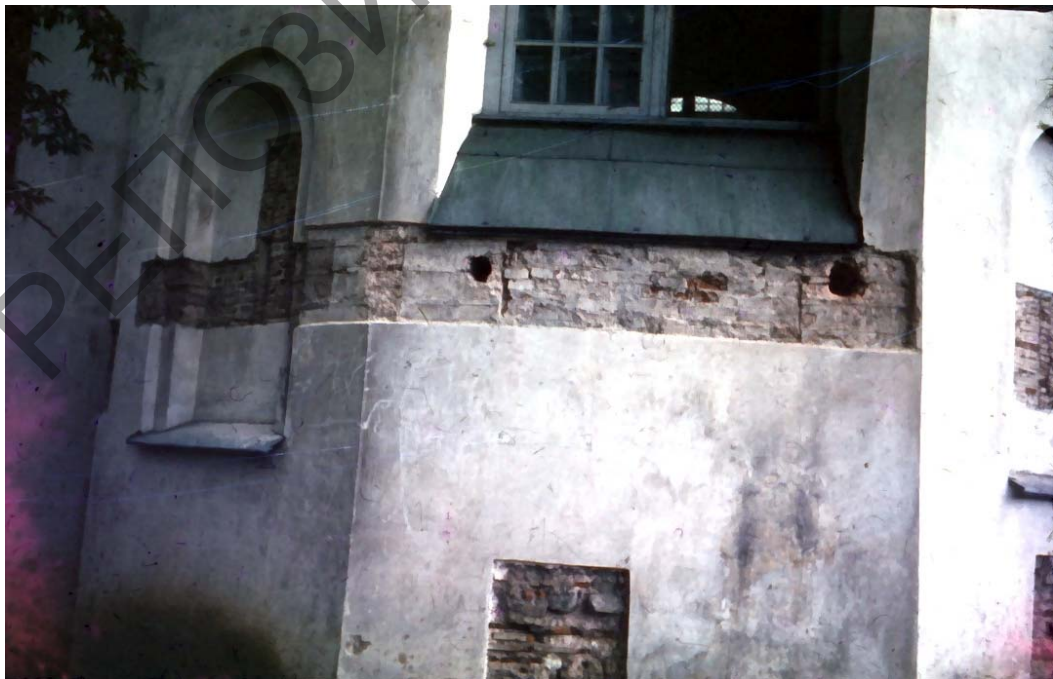
83. Полацкі Сафійскі сабор. Круглыя адтуліны для мацавання рыштаванняў. Фота аўтара, 1981 г.
