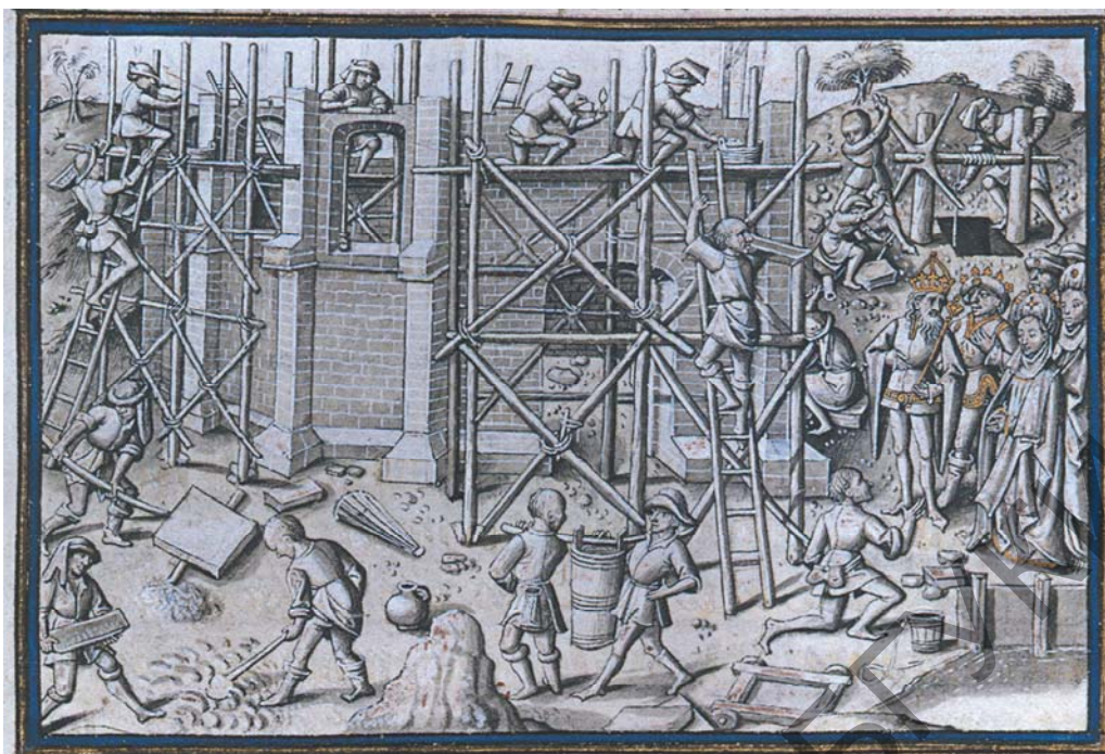
154. Система рихтавання на французській будівлі XV ст. Паводле В.Левандаїскаса
