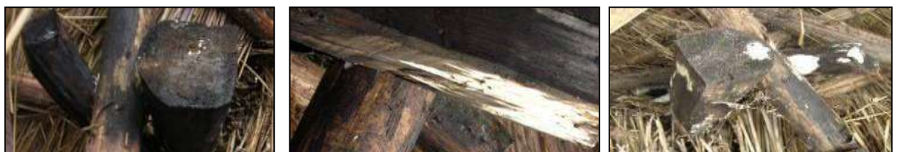
Мал. 4.2.10. - Развіццё Coniophora puteana на апрацаванай драўніне кроквеннай канструкцыі пры затрымцы рамонтных прац
