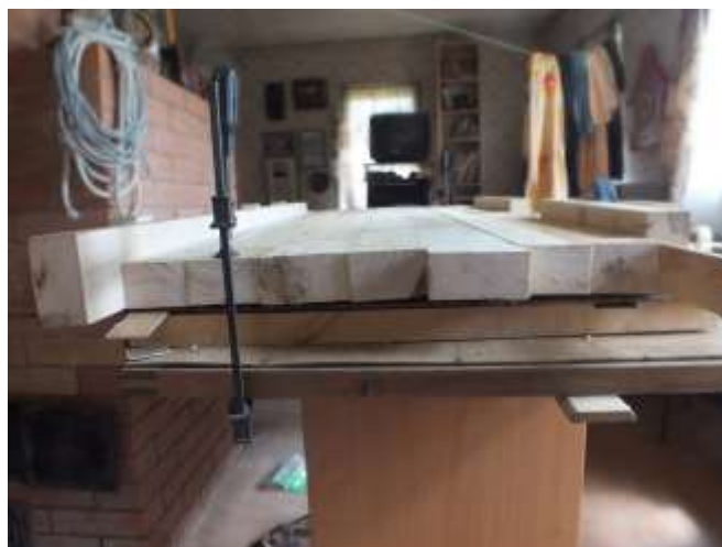
Рис. 5. Для избежания деформации щита его фиксируют с торцов струбцинами расположенными вертикально.
